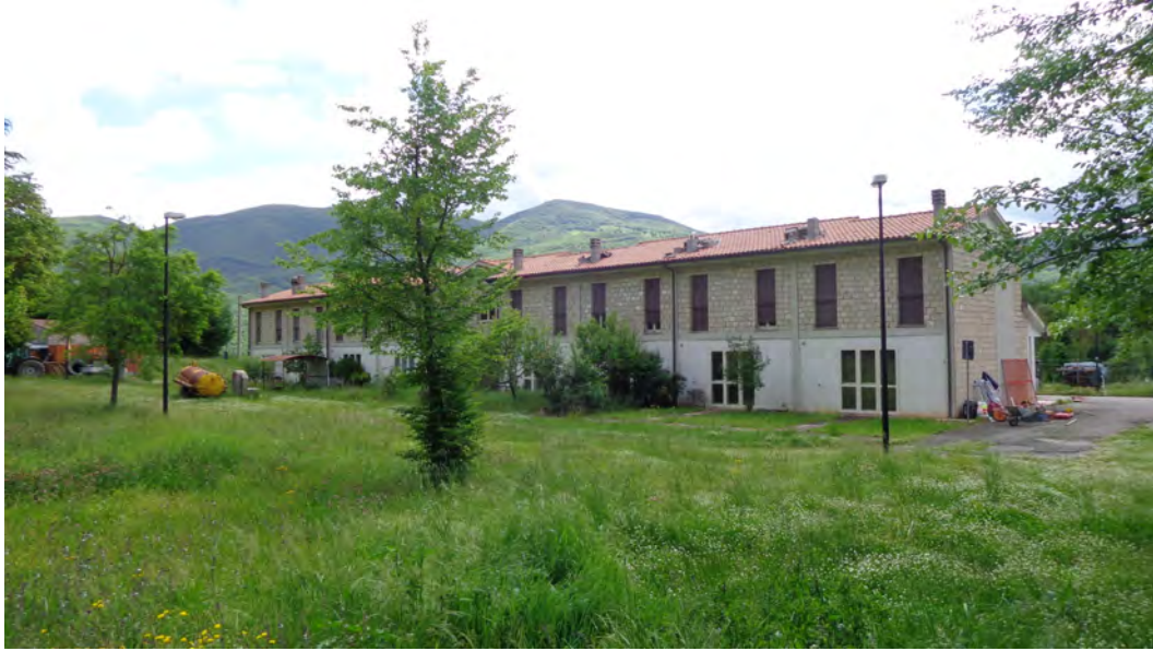
Vista posteriore dell'edificio
