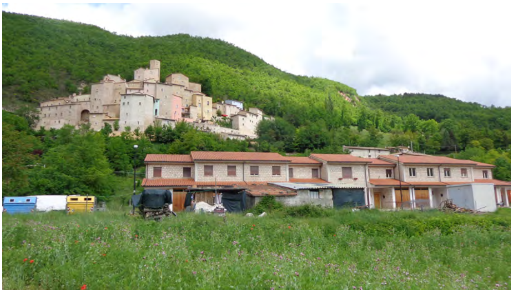
Vista anteriore dell'edificio
