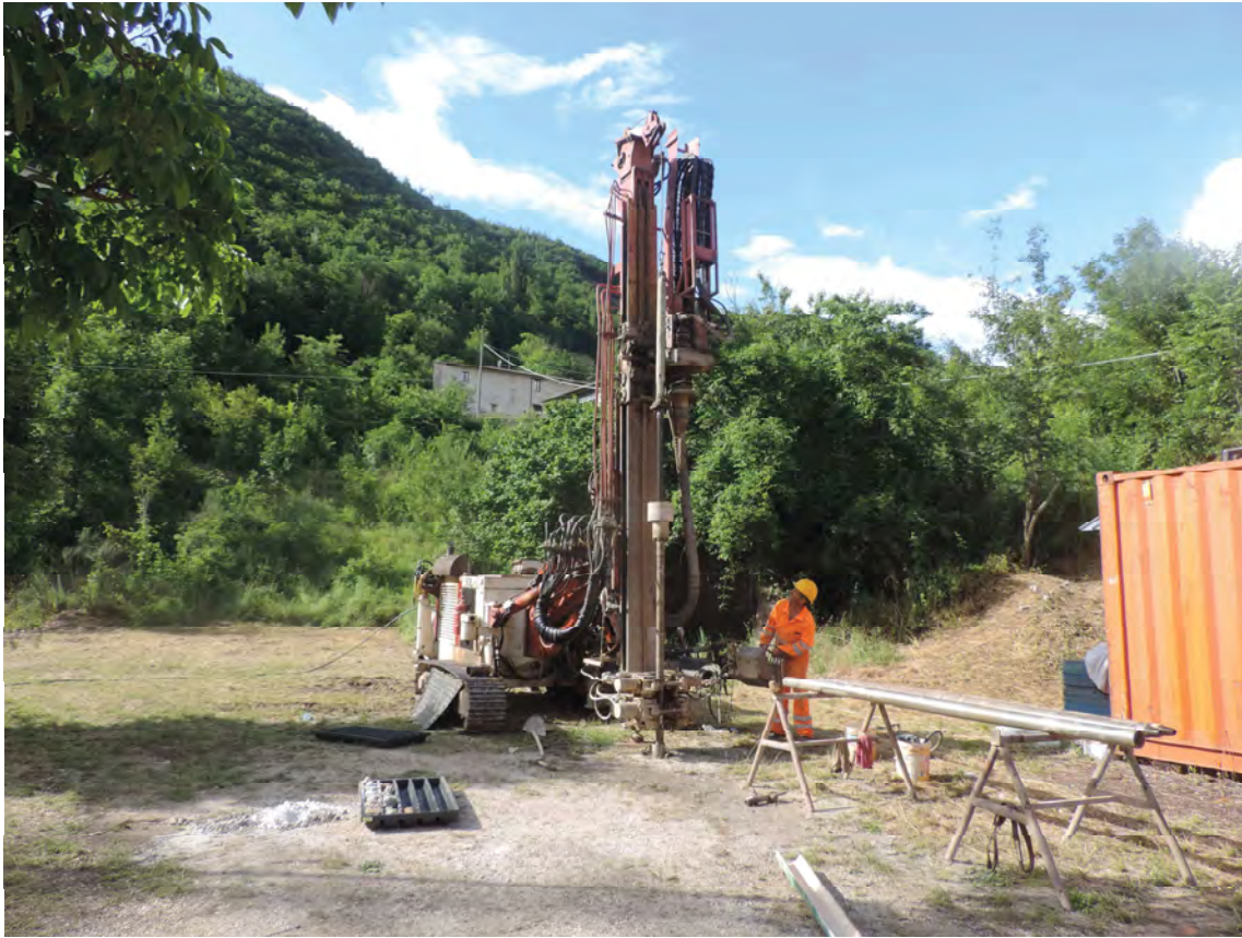
Foto 5: l'esecuzione del sondaggio S2
